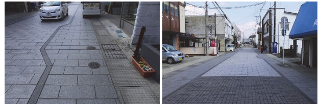
写真2 景観形成と速度抑制を図った舗装パターン (門前通り)
