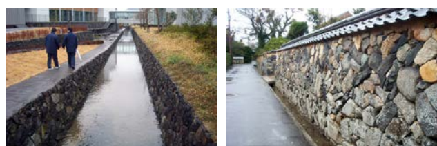
写真-3 歴史的風致に配慮した土木施設の整備（萩市） 左) 藍場川石積み護岸、右) 堀内・平安古地区石塀
