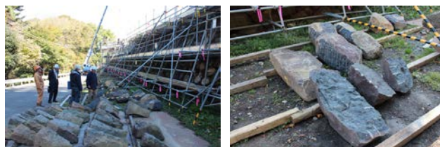
写真-2 ストックを有効利用した仙台城の石垣修復
